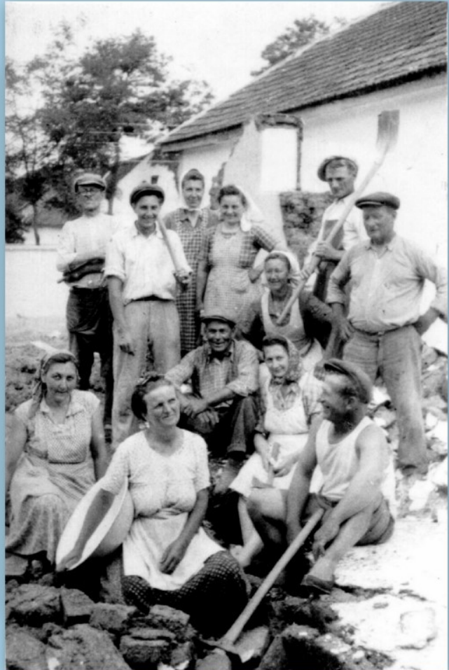
Helfer beim Abriss der Metzgerei in der Hauptgasse. Fotos Archiv Peter Kassnel
